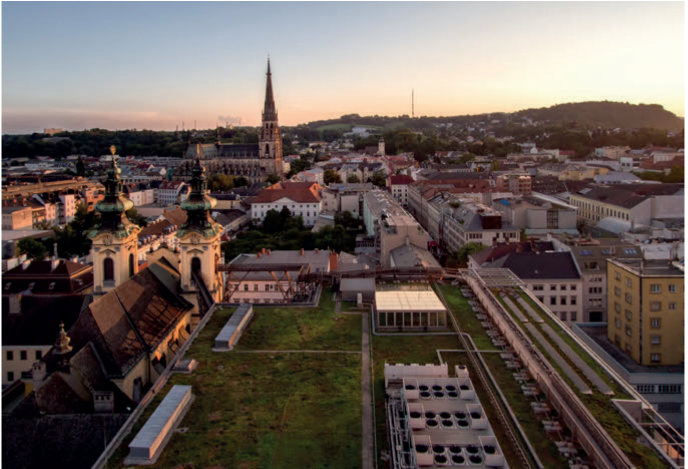
Dachbegrünung in Linz – bei künftigen Bauprojekten verpflichtend.
