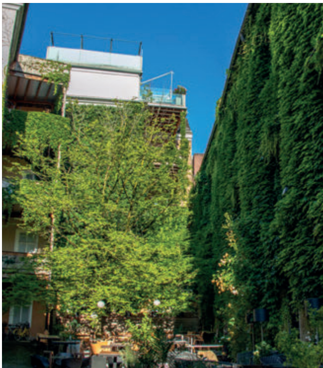
Kühlende Fassadenbegrünung in der Stadt Linz.
