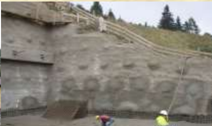
SPRITZBETONSICHERUNG – Gäste- und Apartmenthaus Obertauern
