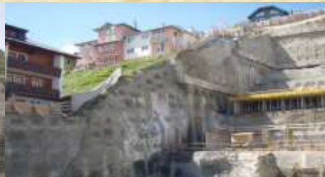
SPRITZBETONSICHERUNG – Gäste- und Apartmenthaus Obertauern
