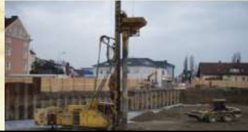
RÜTTELSTOPFVERDICHTUNG
