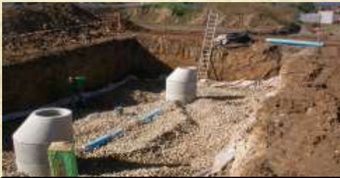
Rigolversickerung
