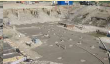
BETONSTOPFSÄULEN
