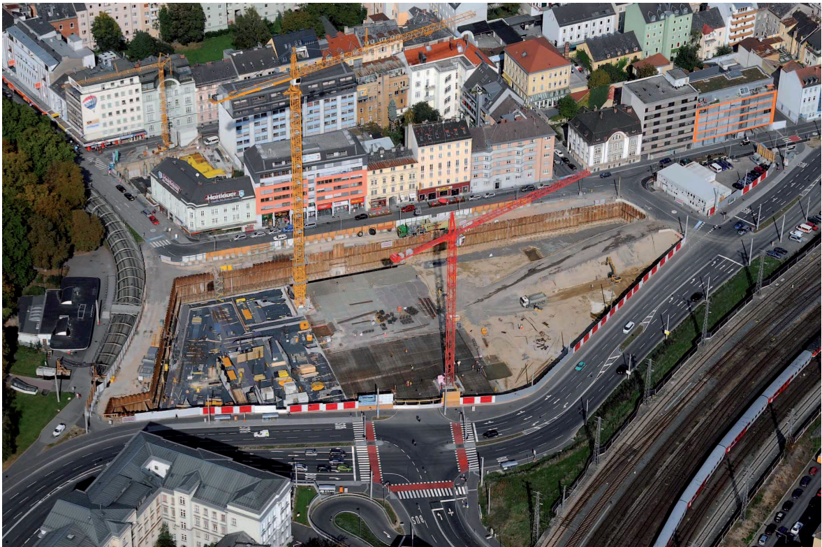
Abbildung 4: Baustelle am 8.10.2009 (Quelle MTG)
