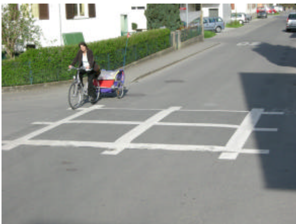
Erhöhtes Belagskissen; Animiert zu vorsichtigen, verlangsamten Fahrgeschwindigkeiten; Kann im Quartierstempo von 30 km/h problemlos überfahren werden.
