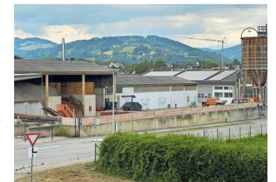
Der Wirtschaftshof in Wolfsberg wurde zur Energiezentrale ausgebaut KLZ/FRIEDL
